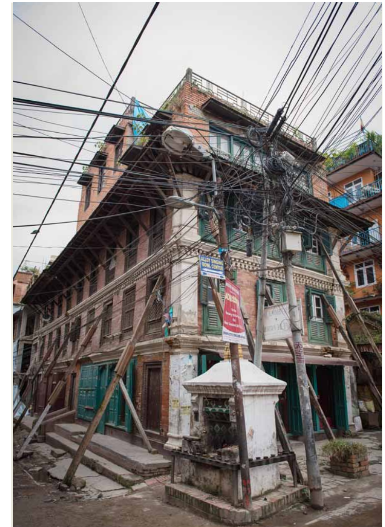
Holzpfeile stützen Häuser seit dem Beben, wie hier in Patan, südlich von Kathmandu.
