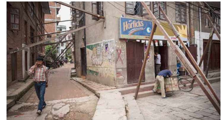
Holzpfeile stützen Häuser seit dem Beben, wie hier in Patan, südlich von Kathmandu.
